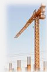
Auf der Dauerbaustelle
